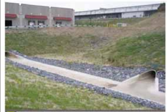
Stormwater conduit
